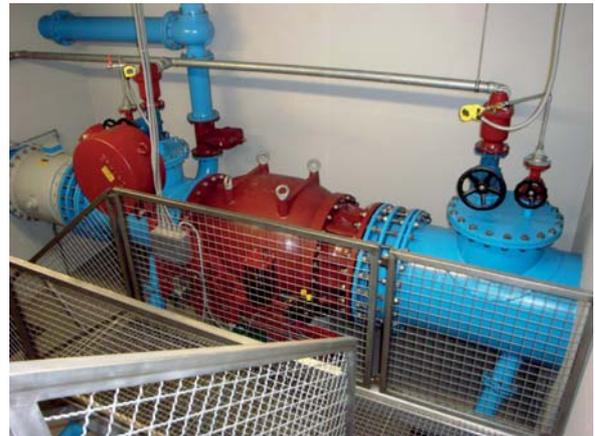
Abb. 14. Rohrbruchsicherung (N-ERGIE, Archiv).
