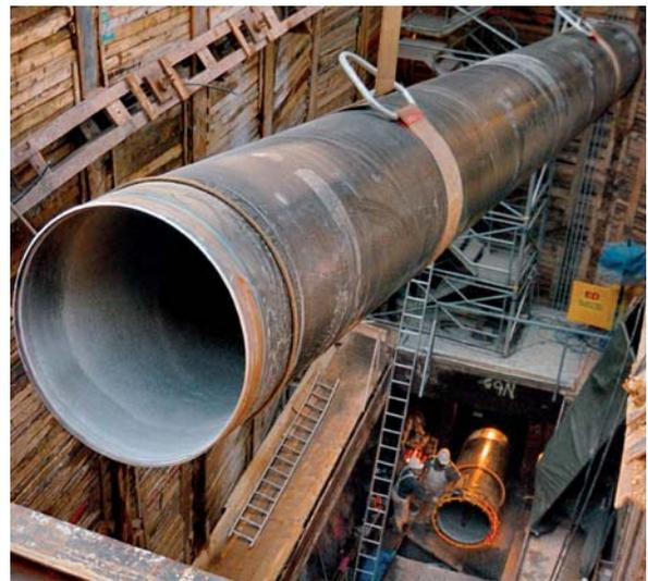
Abb. 15. Ablassen einer Stahlleitung DN 1.000 (Franken-Magazin 7, 2007, 7).
